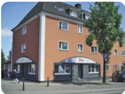
Umbau der Gewerbefläche und der Eingangsbereiche sowie Neuanstrich der Fassade (s. auch Artikel auf S. 10)
