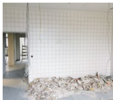
Hier wurde bis vor kurzem noch operiert.
