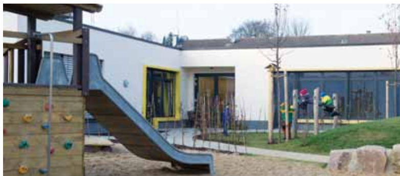
Die Kita verfügt über eine gelungene Außenfläche.
