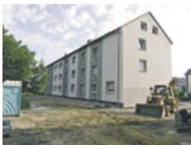
Noch fehlen im 3. Bauabschnitt die Balkone
