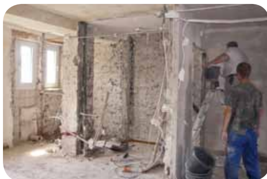
Ein Wohnungsumbau: Das schöne fertige Bad und die vorherige Baustelle
