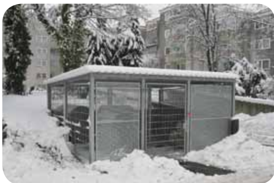
Neues Müllhaus, An der Mähre 2-6
