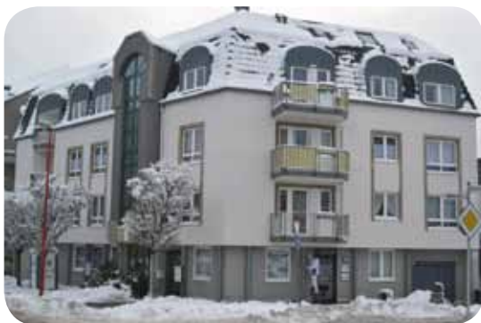
Fassaden- und Balkonsanierung, Offerstr. 2
